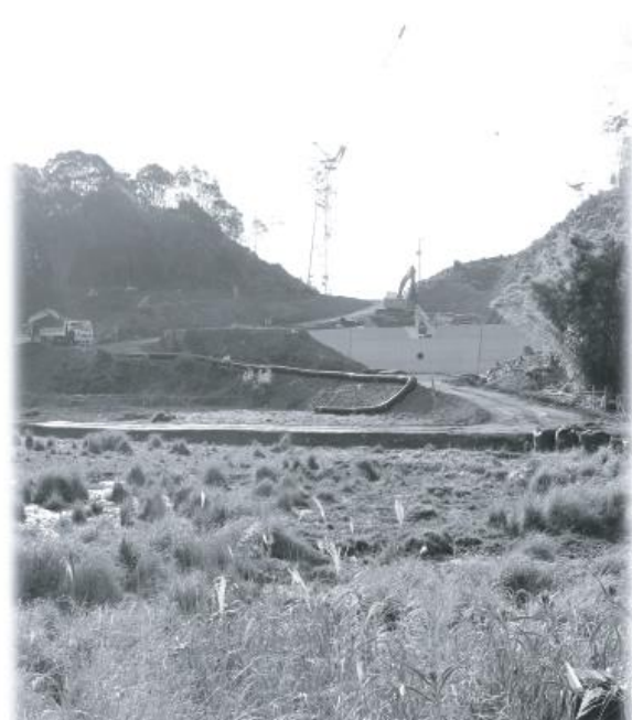
海部病院への避難路整備工事
