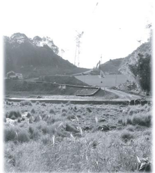
海部病院への避難路整備工事
