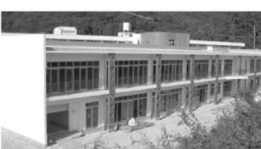
完成間近い小学校校舎
