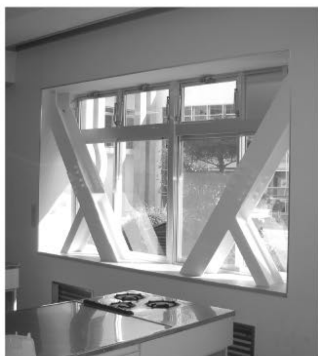
耐震改修の済んだ中学校校舎
