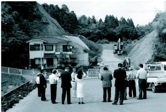
海部病院移転先工事
