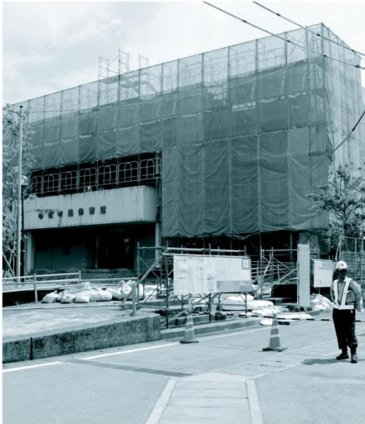
町民体育館の耐震工事
