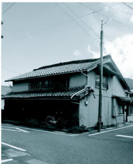
町内での空き家
