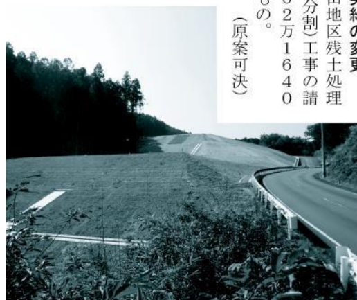
山田地区残土処理場
