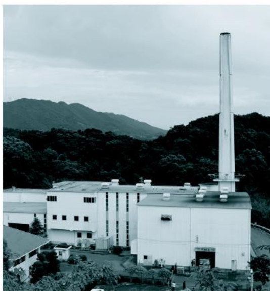
老朽化が進む美化センター
