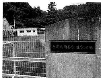
出羽島簡易水道水源地
