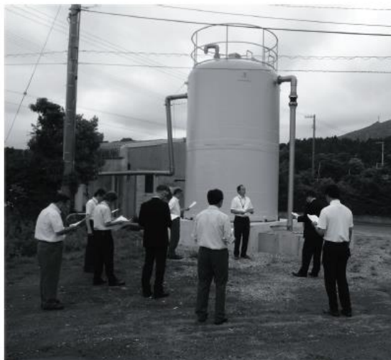
アワビ種苗生産施設 逆洗タンク（古牟岐）
