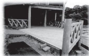
【モラスコむぎウッドデッキ修繕】
