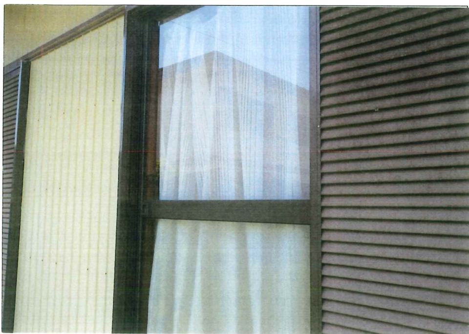
外部開口 単板ガラス
