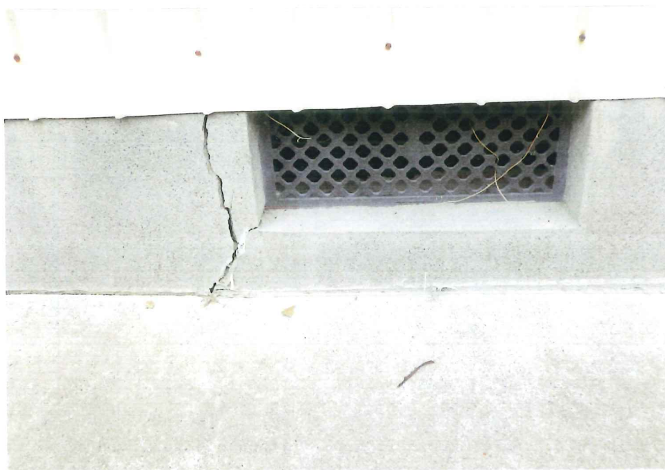
2-① 地盤の沈下による基礎の割れ。
