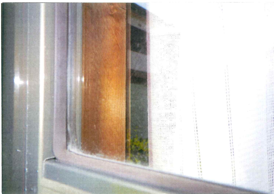
外部開口 単板ガラス
