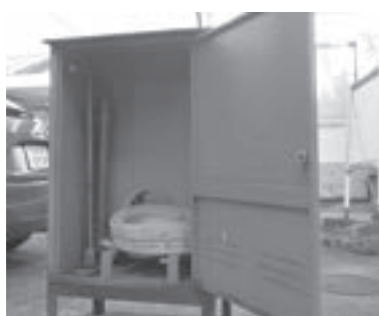
ホース格納箱の中
