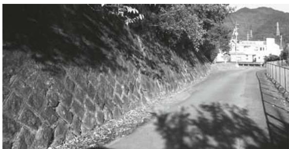
急傾斜地崩壊対策工事（杉谷地区）
