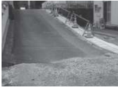
町道大谷2号線 路面沈下による道路修繕工事
