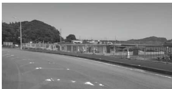
古牟岐港付近の転落防止柵の老朽化による取替工事で、施工延長75メートル
