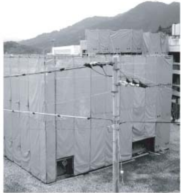
小学校建設工事
