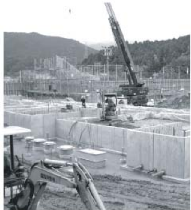
保育所建設工事
