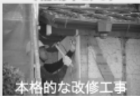
本格的な改修工事
