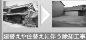
建替えや住替えに伴う除却工事
