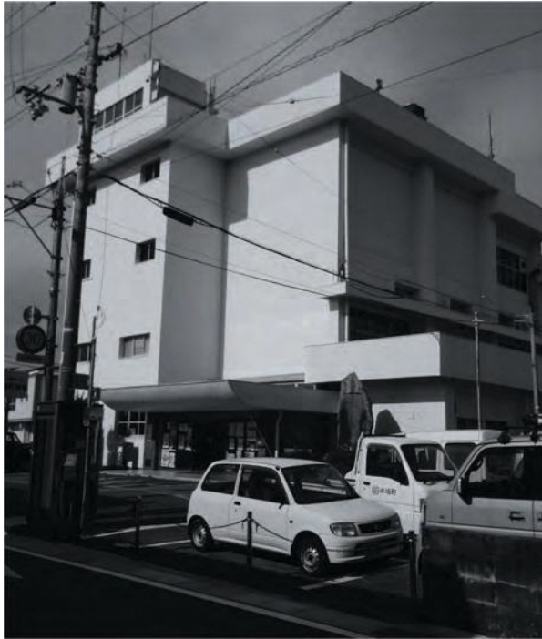
津波浸水区域内にある庁舎
