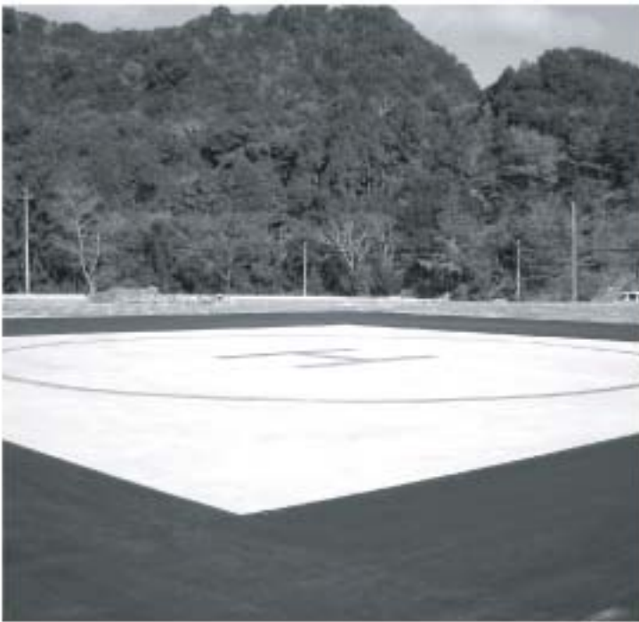
大戸地区に完成したヘリポート
