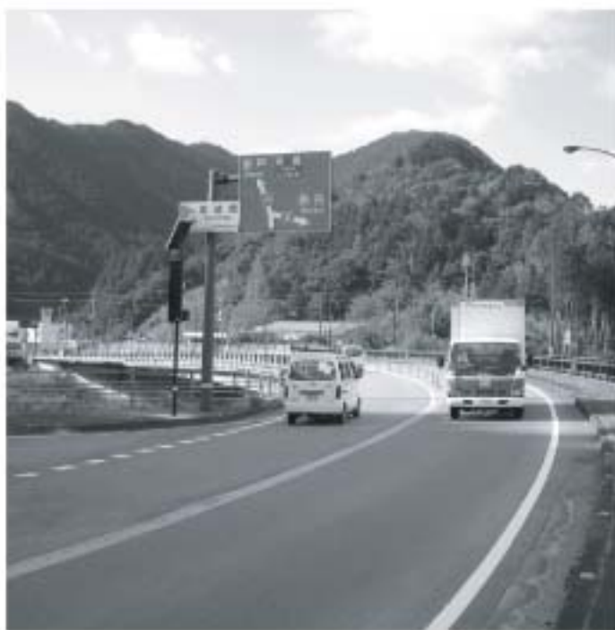
国道55号牟岐橋付近
