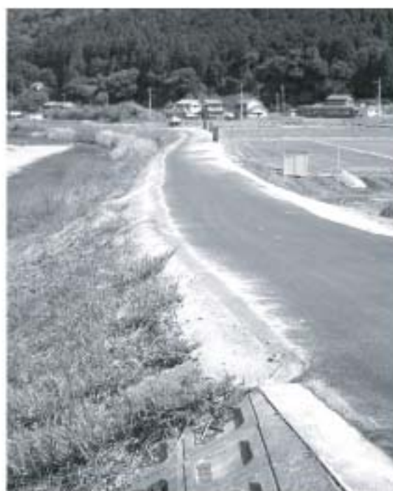
舗装された牟岐川堤防(川長)
