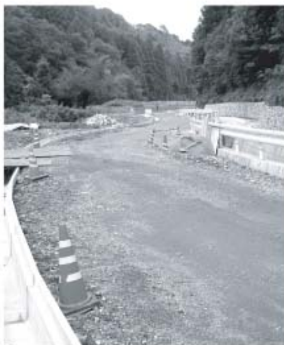
町道大山1号線改良工事
