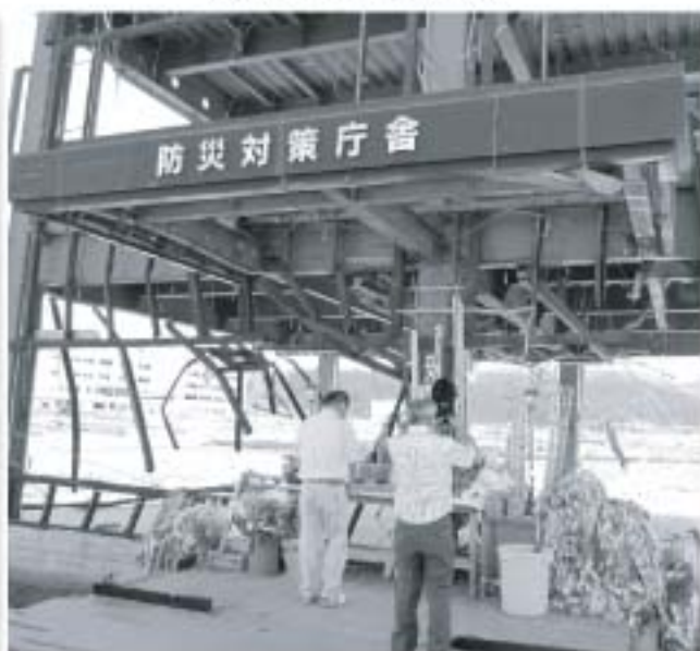
南三陸町防災対策庁舎
