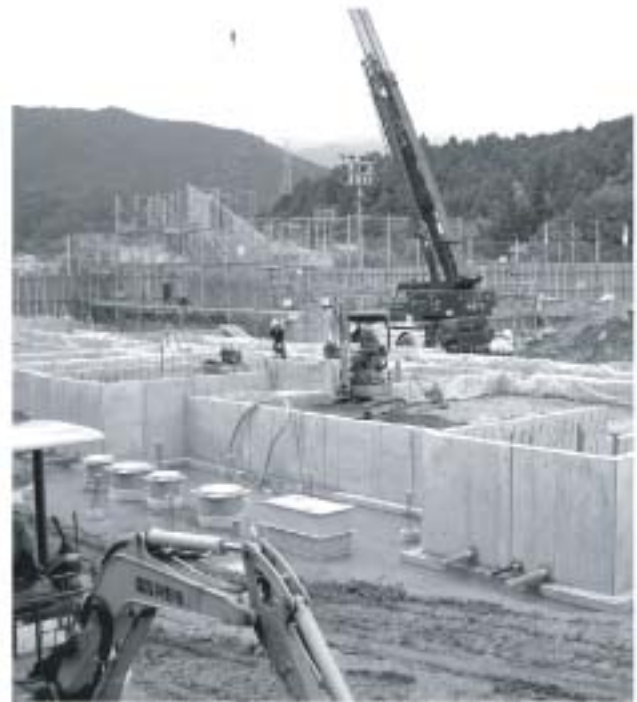
保育所建設工事
