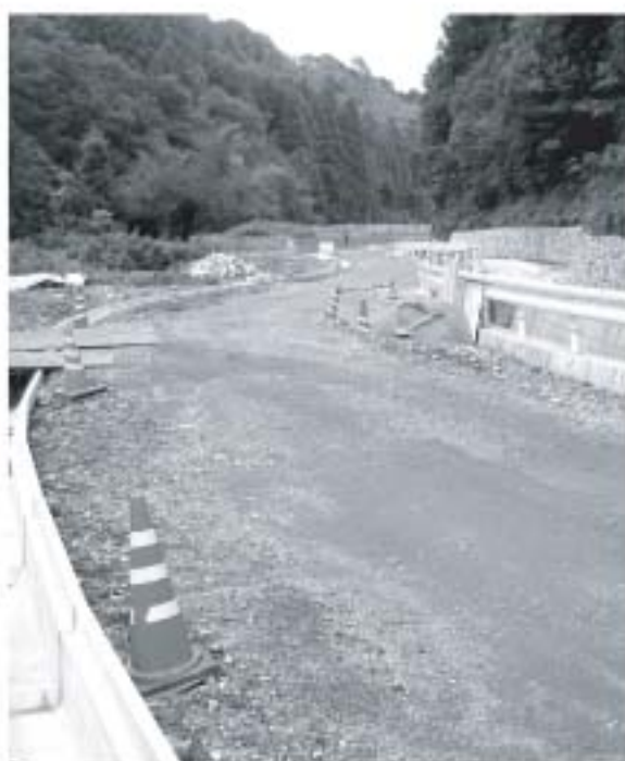
町道大山1号線改良工事
