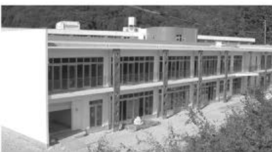
完成間近い小学校校舎
