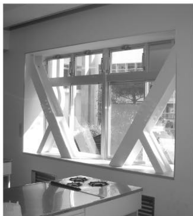
耐震改修の済んだ中学校校舎
