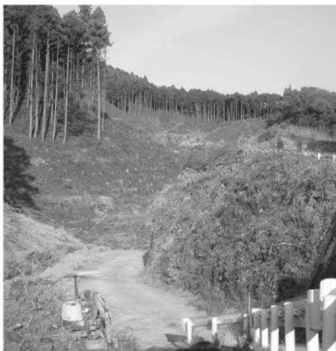
防災拠点避難地整備事業残土処理場
