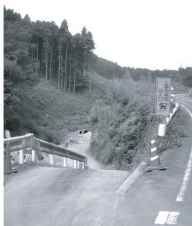
残土処分場 入口
