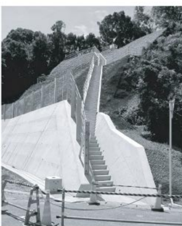
県道日和佐牟岐線自歩道工事
