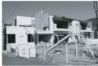
解体中の旧東部保育所
