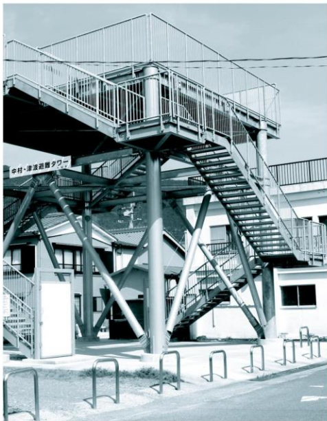
中村津波避難タワー
