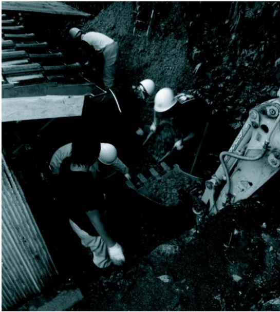
台風被害の復旧作業
