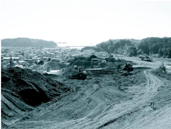
工事が進む病院建設用地
