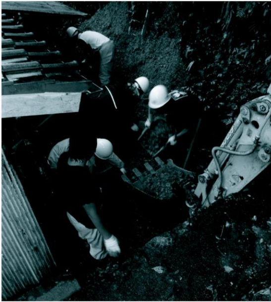
台風被害の復旧作業
