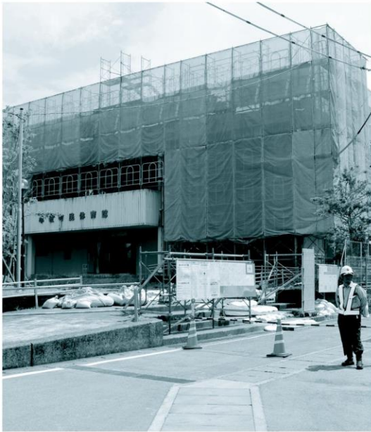
町民体育館の耐震工事
