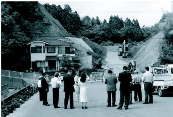
海部病院移転先工事
