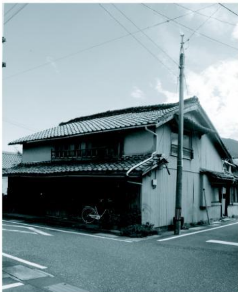
町内での空き家
