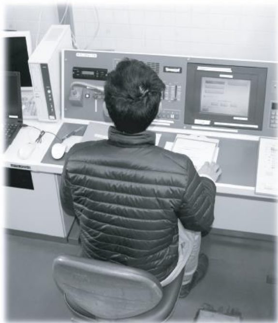
役場庁舎2階に設置の防災行政無線
