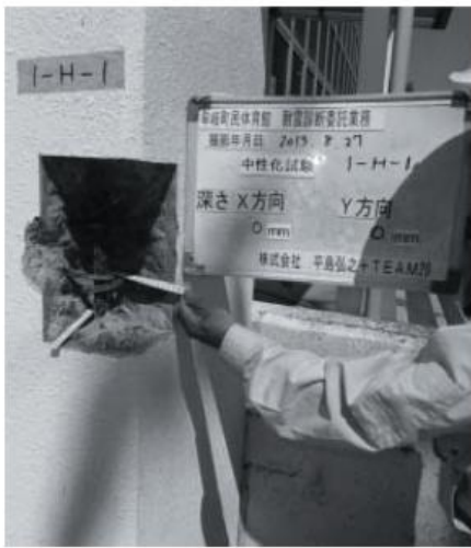
町民体育館の耐震診断
