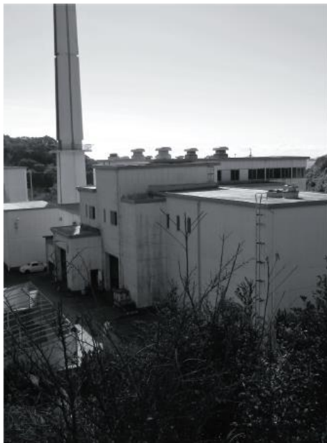
牟岐町にあるゴミ焼却施設
