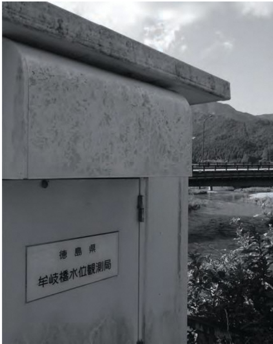
牟岐川の水位計（牟岐橋付近）
