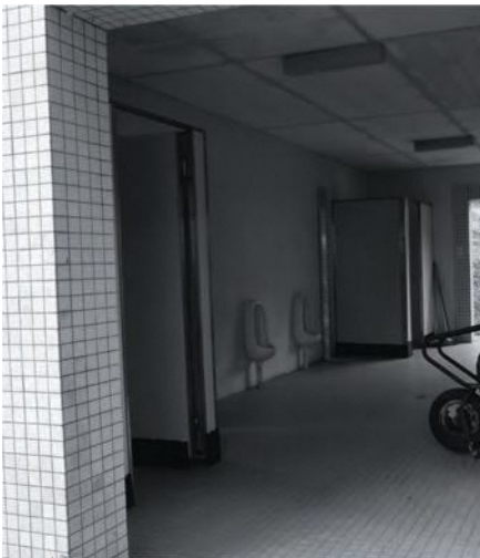
内妻公園内にあるトイレ
