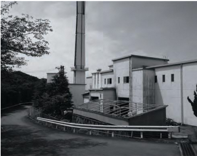
牟岐町にあるごみ焼却施設
