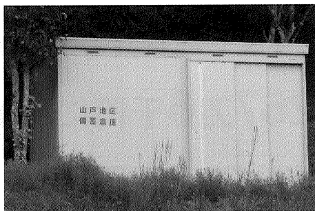
備蓄倉庫 (川長山戸地区)
