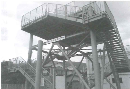
津波避難タワー
