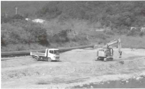
牟岐川河川掘削
