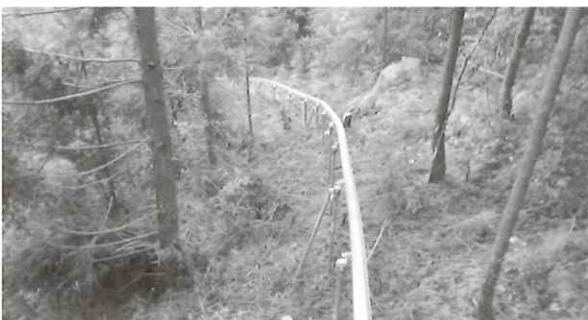
モノレール設置工事 (冷谷)
