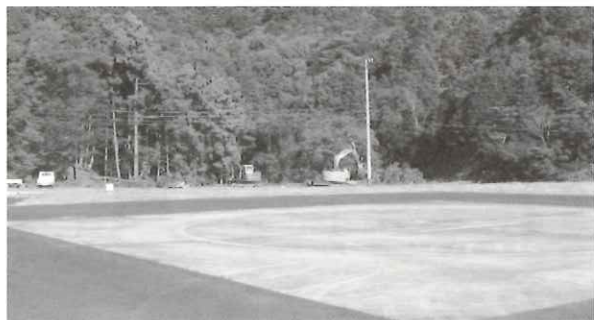
ヘリポートから見た八坂残土処理場
