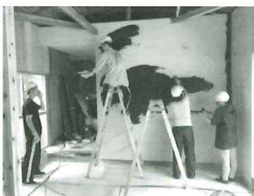
作業場リノベーション
