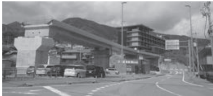
建設中の牟岐バイパス
