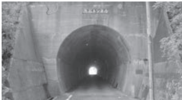
奥谷トンネル
