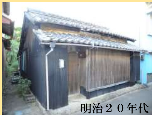
土庇の下の空間を部屋に取り込んでいる例
